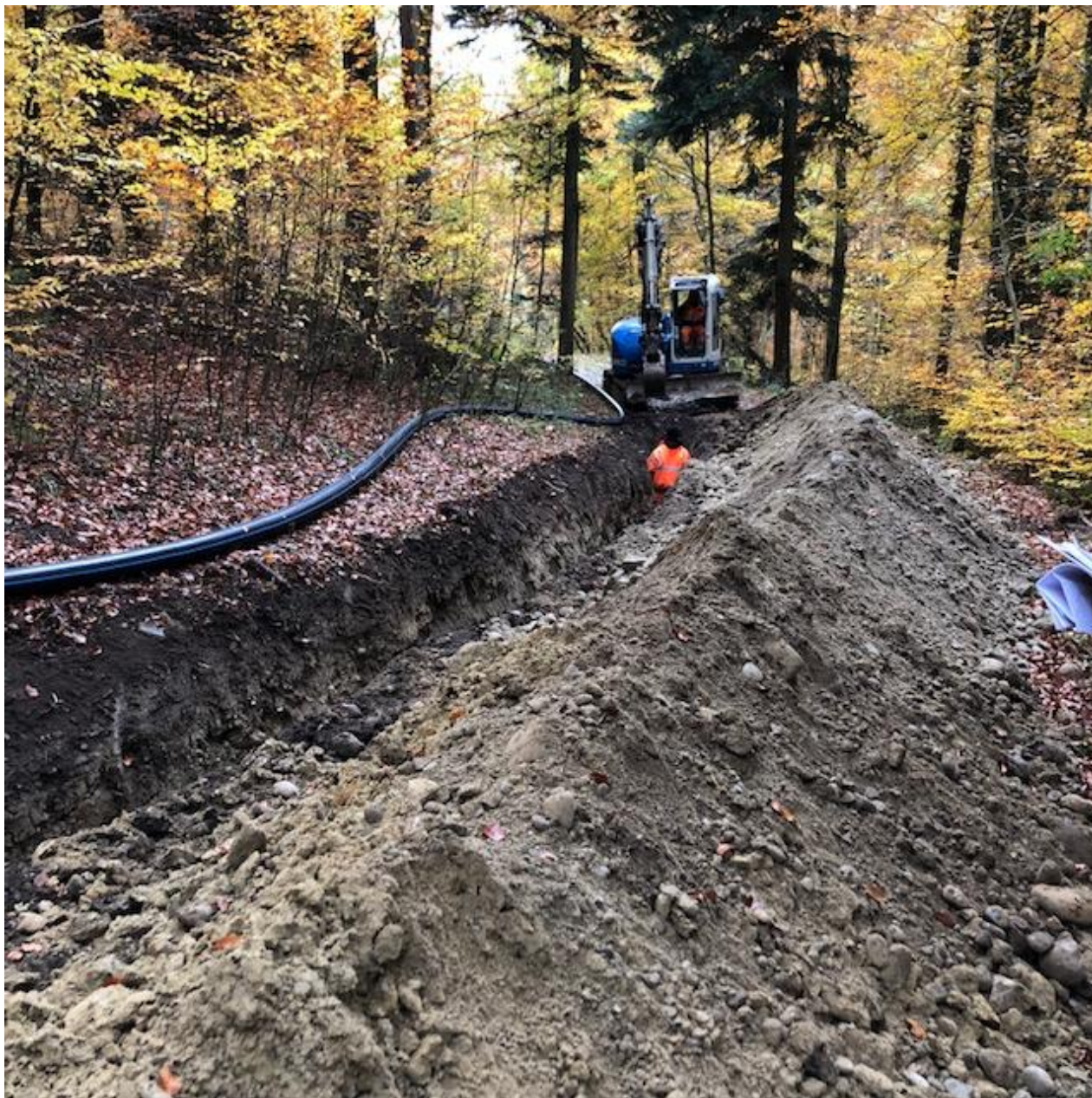
Schweizer Seite – Graben für neue Quellableitung Kressenberg, Bild Urs Müller
