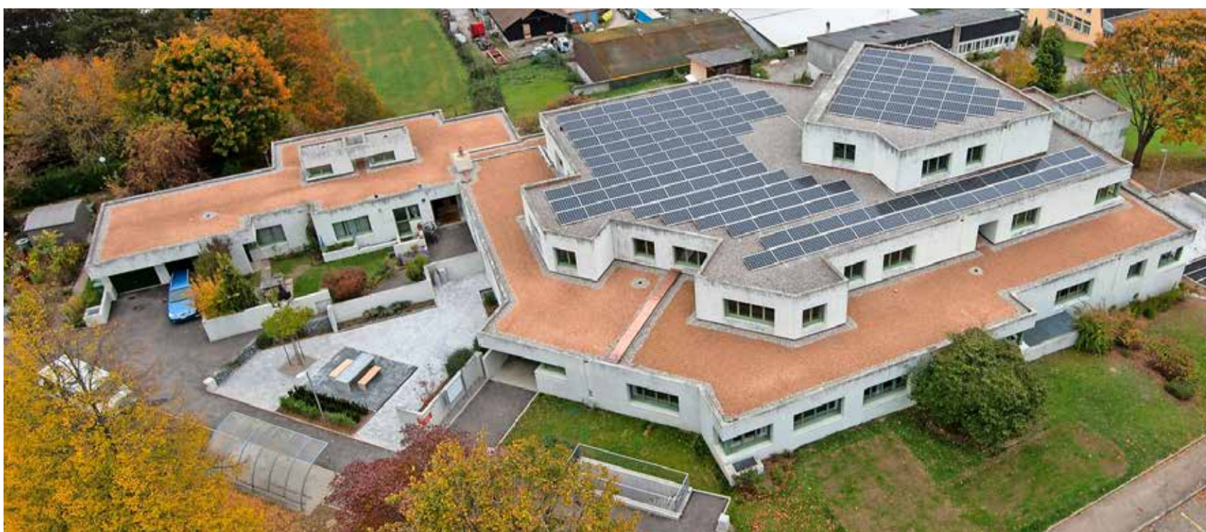
Auch von oben muss die Solaranlage auf der Kirche St. Konrad in den Kontext des Gebäudes passen – so wollte es die Denkmalpflege.
